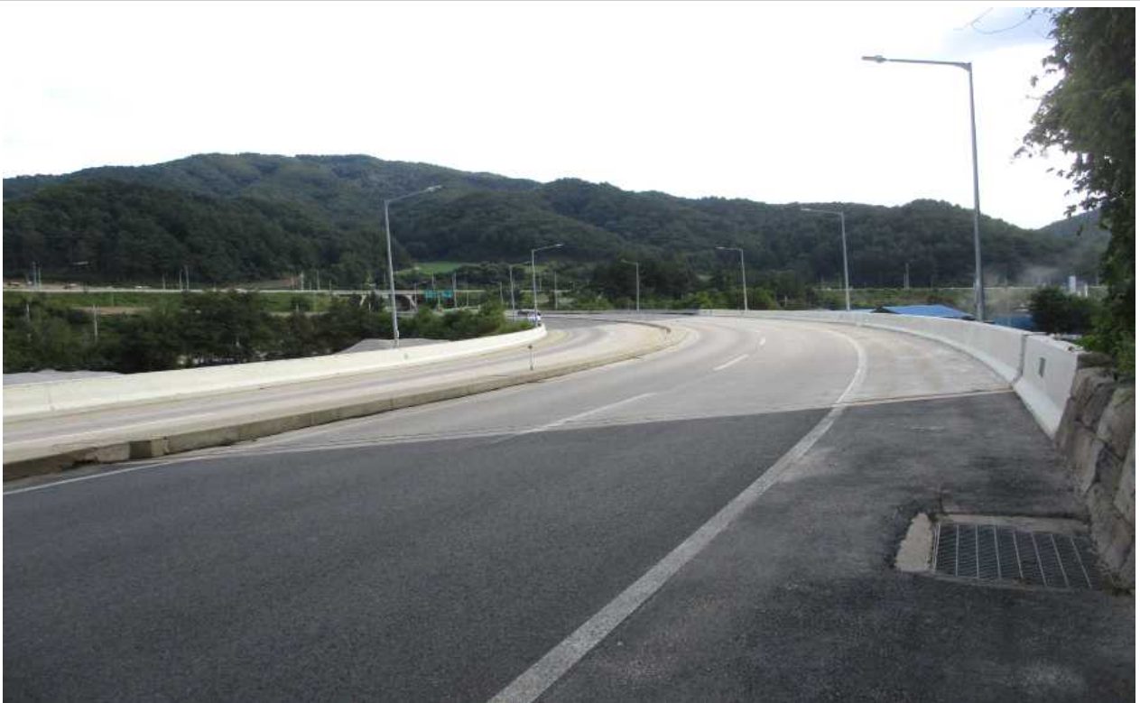
교량 상부 전경
